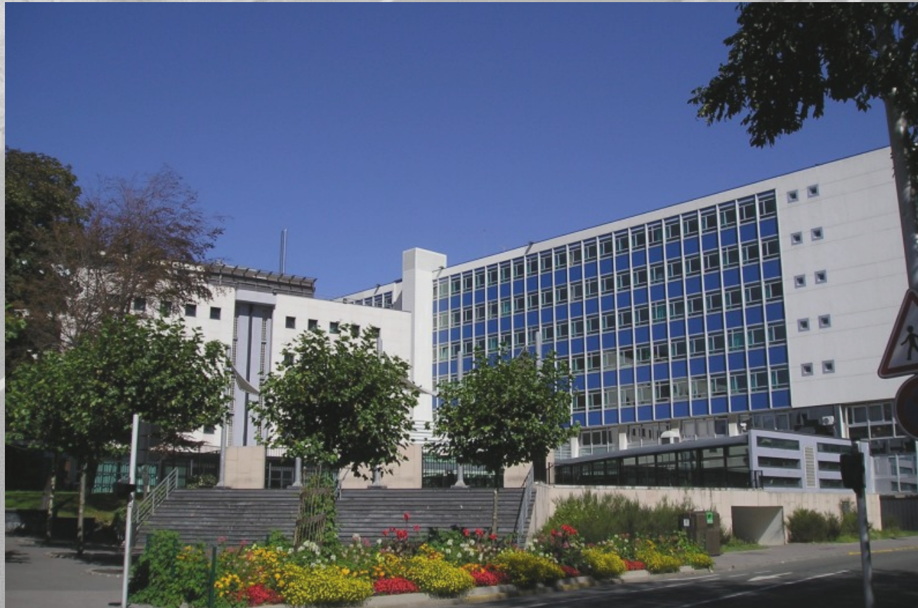
Lycée Branly - Boulogne sur mer
