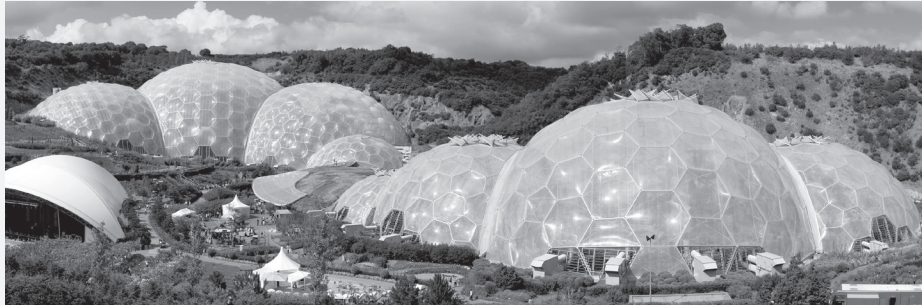
Les dômes de l'Eden-Project réalisés en ETFE (crédits : Jürgen Matern / Wikimedia Commons)
