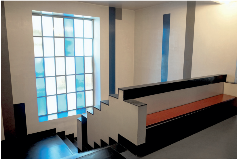
Retournement et transformation du garde- corps en un banc intégré Photo © Michel Bayer
