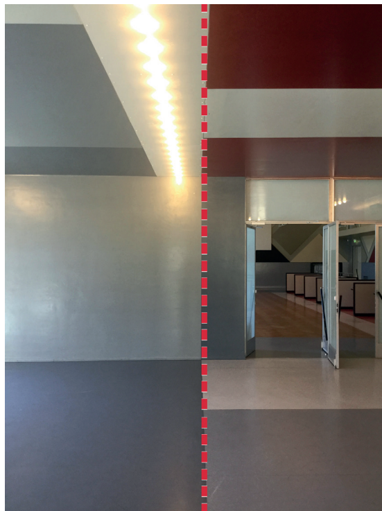
Une ligne de rupture dans le calepinage Photo © Michel Bayer
