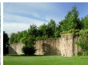
Gilles Clément (1943- ), L'île Derborence , 1992, construction centrale dans le Parc Henri Matisse qui accueille 3500 m 2 de nature. Lieu inaccessible, sans aucune intervention: fragment de Tiers-paysage placé à 7 m au dessus du niveau du sol, espace de diversité. Construction béton, parois moulées dans la masse de terre issue des travaux de la gare TGV, parc Henri Matisse, Lille, France.
