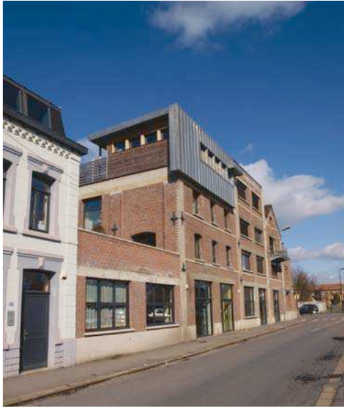
Quai des Mines, Valenciennes
