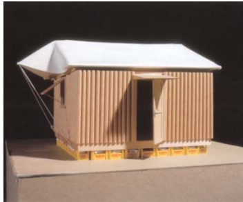
Shigeru Ban (1957 - ), Paper Loghouse , 1995, tubes de carton (diamètre : 10,8 cm / épaisseur : 4 mm), fondations : caisses de bière chargées avec des sacs de sable, toiles pour la réalisation du plafond et de la toiture, joints waterproof entre les tubes, coût de 200 dollars, maison de 16 m 2 , Kobe, Japon.
