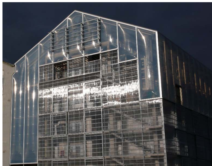
Photographie réalisée avant la fin du chantier (septembre 2013).
