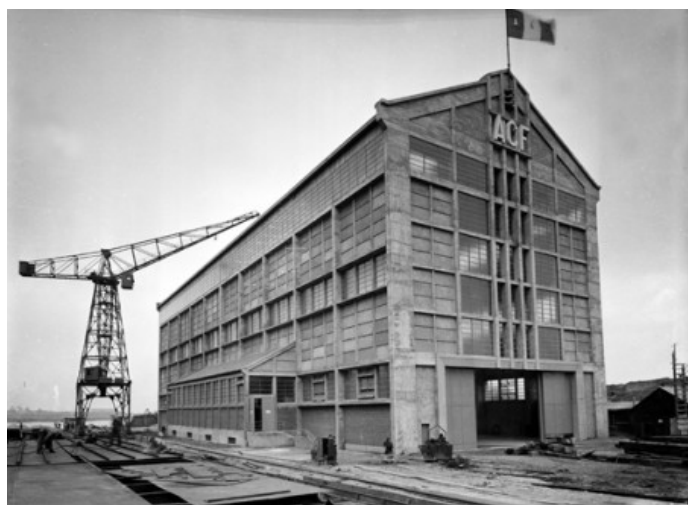
Dimensions de l'AP2 : 75 mètres de long, 25 mètres de large, 25 à 30 mètres de haut.
