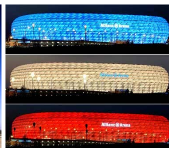
Jacques Herzog (1950 -), Pierre de Meuron (1950 -), Allianz Arena , 2002-2005, enveloppe translucide réalisée avec des coussins d'air sous pression en polymère (ETFE), Munich, Allemagne.
