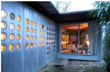
Jean Prouvé (1901 - 1984), Maison de Jean Prouvé , 1954-1953, n° 6 rue Augustin-Hacquard, sur le flanc de la colline dominant le nord de la ville, en contrebas du quartier du Haut-du-Lièvre. Nancy, France.
