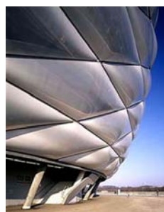
Jacques Herzog (1950 -), Pierre de Meuron (1950 -), Allianz Arena , 2002-2005, enveloppe translucide réalisée avec des coussins d'air sous pression en polymère (ETFE), Munich, Allemagne.
