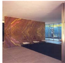
Ludwig Mies van der Rohe (1886 - 1969), pavillon allemand de Barcelone, construit pour l'exposition universelle de Barcelone en 1929, détruit et reconstruit ensuite à l'identique, marbre, travertin, onyx rouge, inox, la structure en elle-même est constituée de huit poteaux en acier à section cruciforme, Barcelone, Espagne.
