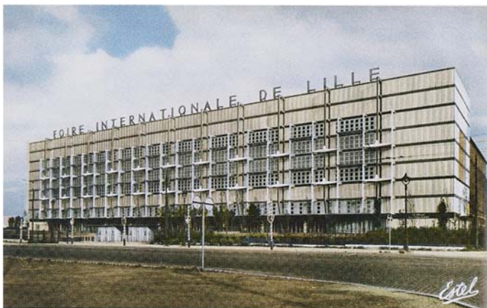
Jean Prouvé (1901-1984), structure métallique de la façade du Palais de la Foire de Lille, 1950-1951, structure de 2,5 m d'épaisseur s'appuyant sur l'ancienne construction des architectes Paul Herbé et Maurice Louis Gauthier de 1934, Lille, France.
