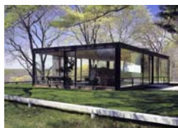
Philip Johnson (1906 - 2005), The Glass House , 1949, New Canaan, Connecticut, États-Unis.
