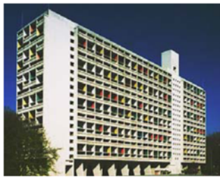
Le Corbusier (1887 - 1965), Unité d'habitation de Marseille (Cité Radieuse), 1945-1952, ensemble architectural de 18 niveaux, composé de 337 appartements en duplex, de rues intérieures, d'une école maternelle, d'un gymnase, d'un hôtel, de commerces et de bureaux, 137 x 24 x 56 m, 280 boulevard Michelet, Marseille, France.
