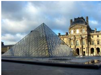
Ieoh Ming Pei (1917 -), Pyramide du Louvre , 1983-1988, 603 losanges et 70 triangles en verre, structure métallique, hauteur : 20,6 m ; base carrée de 35 m de côté, Cour Napoléon du Musée du Louvre, Paris, France.
