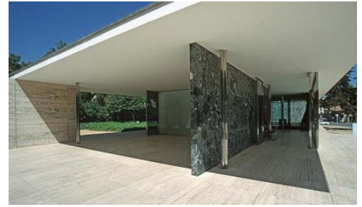
Ludwig Mies van der Rohe (1886 -1969), Pavillon allemand de Barcelone , construit pour l'exposition universelle de Barcelone en 1929 et reconstruit ensuite à l'identique, marbre, travertin, onyx rouge, inox, la structure en elle-même est constituée de huit poteaux en acier à section cruciforme, Barcelone, Espagne.
