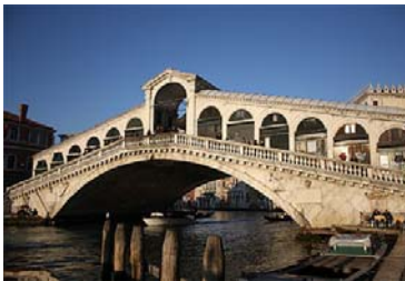
Antonio da Ponte (1512 - 1595), Pont du Rialto, 1588 à 1591, pont en pierre d'Istrie, 48 m de longueur, pont composé de trois passages piétonniers : un au centre entre deux rangées de six boutiques installées dans six arches à la montée et à la descente, les trois allées piétonnières se raccordent au sommet du pont par deux arches de plus grandes dimensions, Venise, Italie.
