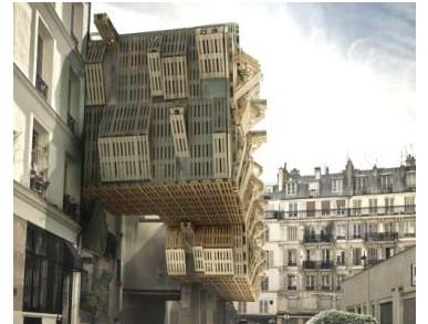
Stephane Malka (1975 - ), AME-LOT , 2011, recouvrement extérieur constitué de modules en palette de bois reliés par des charnières horizontales, Paris, France.
